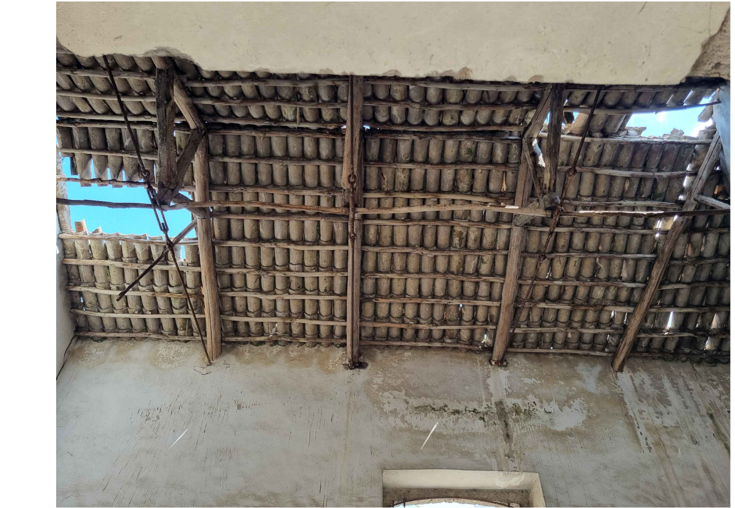
Foto n° 9 Vista di dettaglio dello stato di deterioramento della copertura dell'Edificio C
